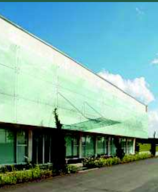
Pura transparência: brise de vidro da Engevidros para a fachada da construtora Triunfo
